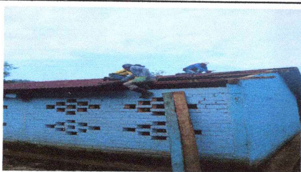
Foto1: MOMENTO EN QUE SACARON LA CUBIERTA DE LAMINA
